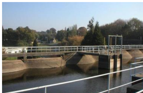
Barrage de Beaufort (Plerguer)
