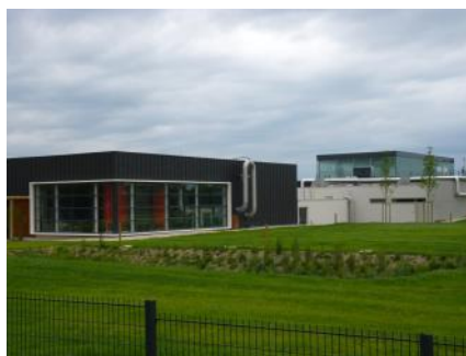
Usine du Bois Joli
