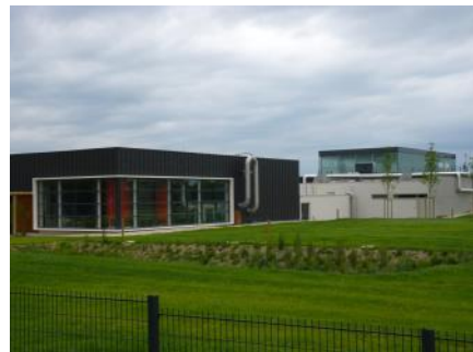
Usine du Bois Joli
