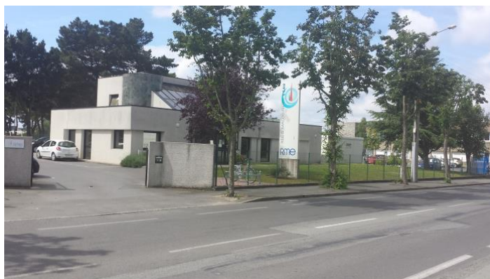
Locaux de la RME au 40 Bd des Déportés
